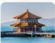
สะพานจางเจียว
